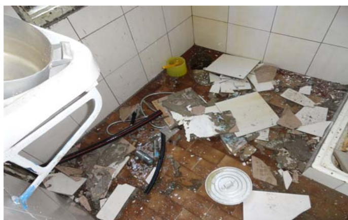
Slika 14 zidovi sa otpalim pločicama u kupatilu
