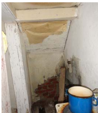
Slika 19 i 20 Izgled ugla kuhinje sa trulim podom i zidom od opeke sa otpalim malterom
