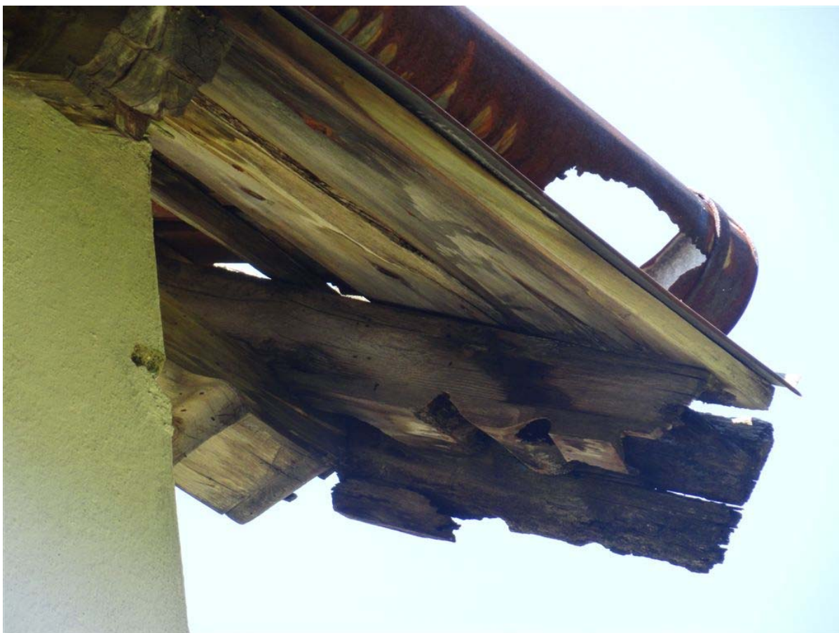
Slika 25,26,27 Stanje drvenih rogova, oluka i opšivke
