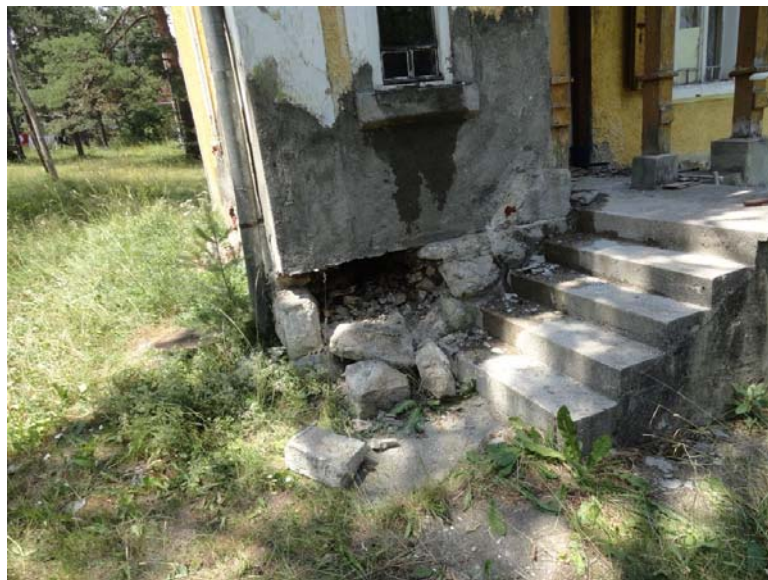
Slika 4 Delovi temelja i zidova od kamena su uršineni
