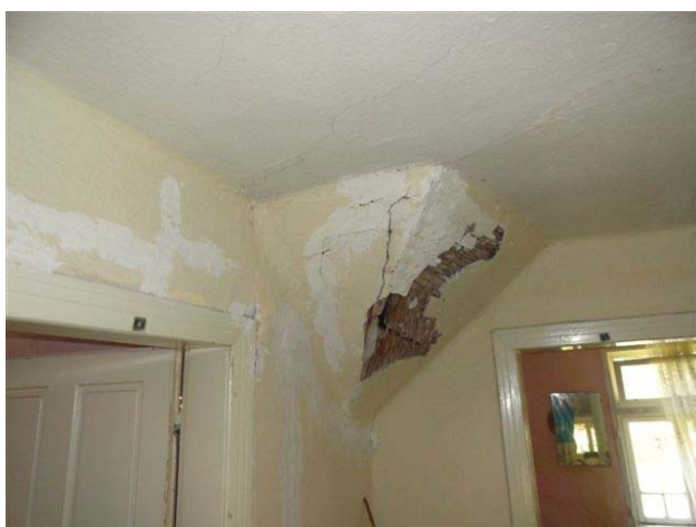
Slika 23 Stanje plafona u hodniku potkrovlja
