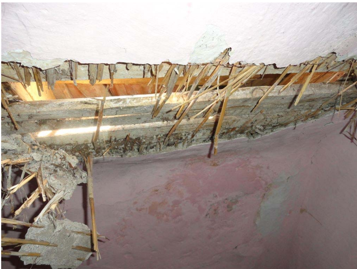
Slika 26 Stanje plafona u sobama potkrovlja
