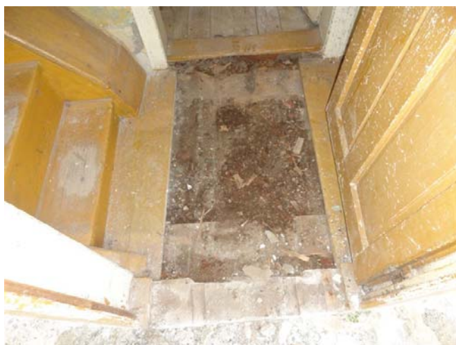
Slika 15 i 16 Izgled ulaznog hodnika sa trulim podom i drvenim stepenicama
