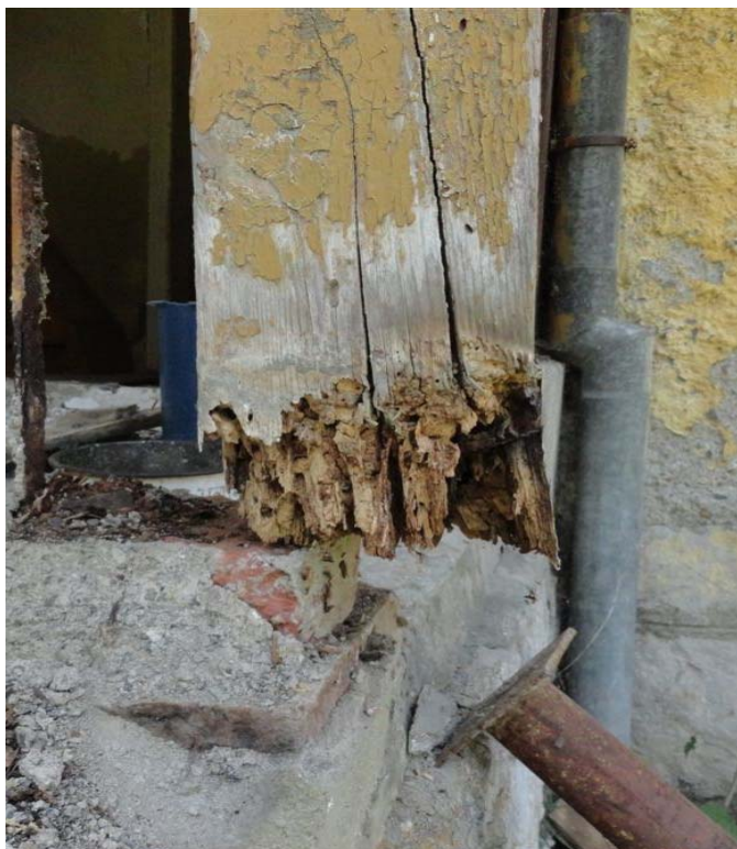
Slika 8,9 izgled istrulelih drvenih stubova
