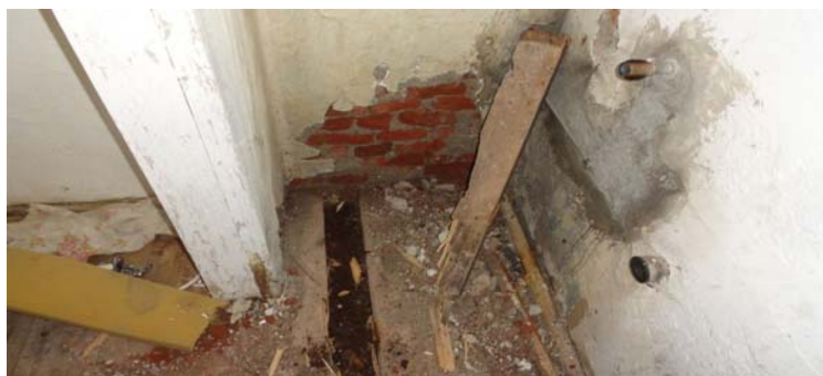
Slika 19 i 20 Izgled ugla kuhinje sa trulim podom i zidom od opeke sa otpalim malterom
