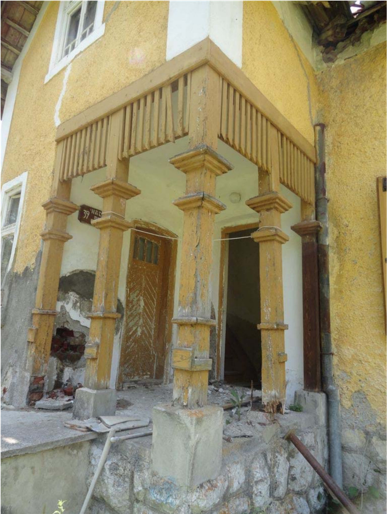
Slika 11 Izgled ulaznog trema i pukotine na fasadi, truo zid od opeke i uništena limarija horizontalnih i vertikalnih oluka .Srednji drveni stub potpuno truo i ispao iz ležišta
