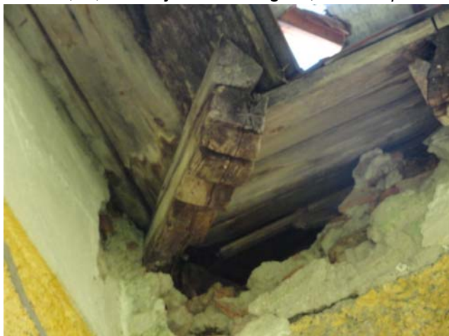
Slika 25,26,27 Stanje drvenih rogova, oluka i opšivke
